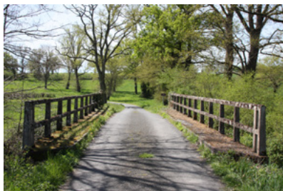
Pont Freyssinet, Gouise
