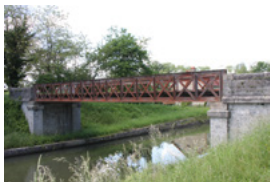
Pont de la Boisé, Gannay-sur-Loire
