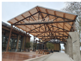
Espace patrimoine Maison de la Rivière Allier
