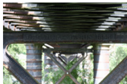
Pont de fer, Moulins
