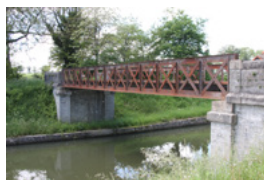
Pont de la Boïse et canal latéral à la Loire, Gannay-sur-Loire
