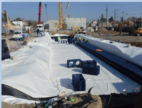
Bassin de rétention, parking de la gare, rue Marcelin Desboutin à MOULINS
