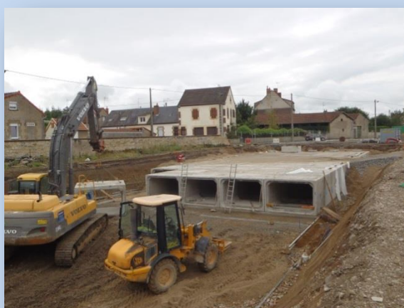
Bassin de rétention, parking de la gare, rue Denis Papin à MOULINS
