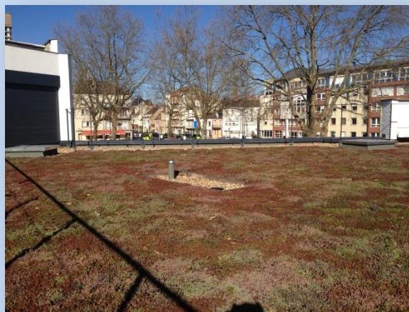
Toiture végétalisée de la Médiathèque communautaire à MOULINS
