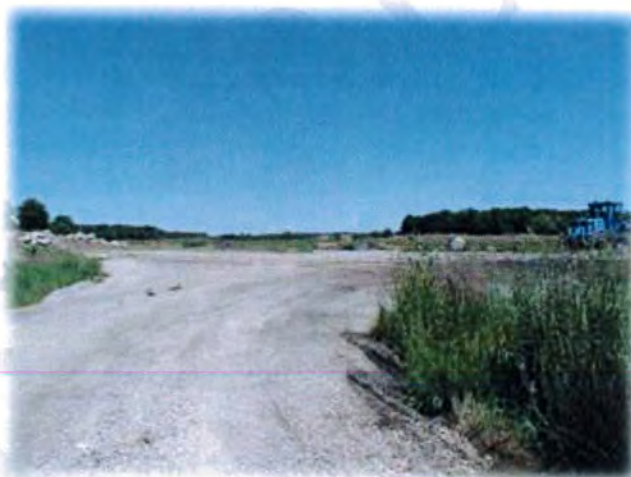
Travaux de voirie (juin 2013)
