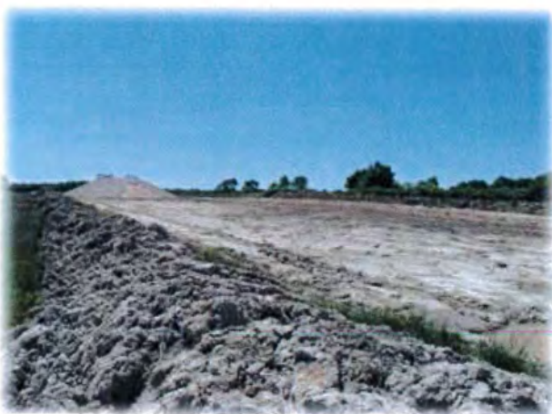
Travaux de voirie (juin 2013)
