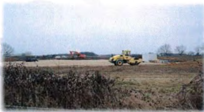
Construction du pont ferroviaire
