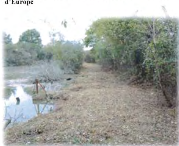
Débroussaillage des digues
