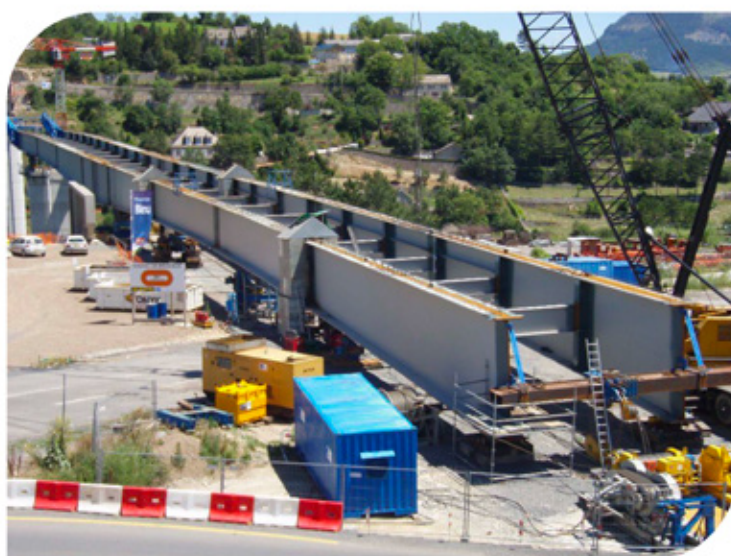
Vue d'ensemble d'une plateforme d'assemblage (@Bouygues TPRF).
