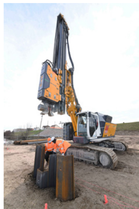
Installation du batardeau (@Ville de Moulins).
