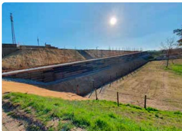
**Côté rive gauche, l'accès a été réalisé au bout du Chemin de Halage, une rampe longue d'une centaine de mètres, afin de permettre l'accès aux personnes à mobilité réduite et habillée d'un mur en bois afin de s'inscrire harmonieusement dans le paysage.**
