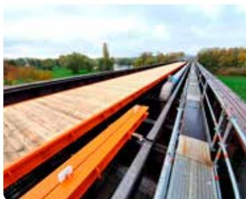
Il est désormais possible de se faire une idée du rendu de l'ouvrage final. La passerelle qui accueillera les promeneurs, piétons et vélos, est en place sur une bonne partie de l'ouvrage. Un plancher de bois provisoire a été installé, le temps des travaux. Il sera remplacé par le plancher définitif, en chêne, dans quelques mois, avant la fin du chantier.
