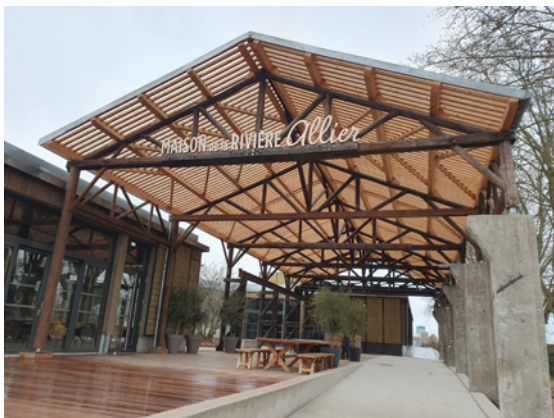
Maison de la Rivière Allier
