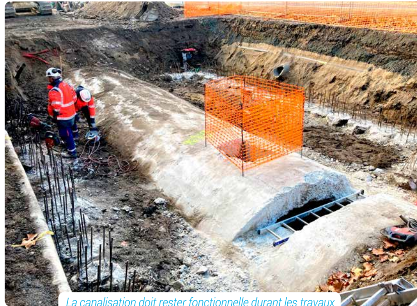
La canalisation doit rester fonctionnelle durant les travaux
