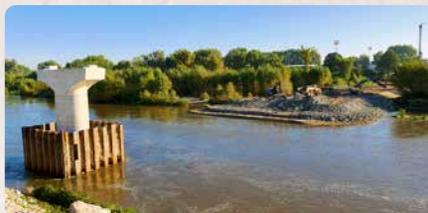
Une étape importante est franchie avec la sortie de terre de la toute première pile du viaduc. Sur l'autre rive, du côté de l'Ovive, les premiers appuis sont également bien visibles. En parallèle et dans le cadre des mesures compensatoires entrainées par la réalisation de ce chantier, les travaux démarrent au niveau de la passe à poissons en rive droite, entièrement rénovée.
