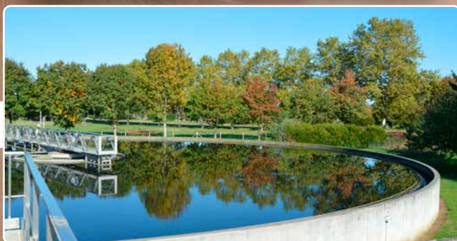
Travaux sur le réseau
