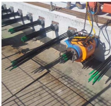
d'induire une force complémentaire au béton afin de comprimer la sous-face du tablier et de tendre l'extrados. Ces forces complémentaires induites par la mise en tension des câbles permettent de reprendre les charges qu'aura à subir l'ouvrage au cours de son fonctionnement.
