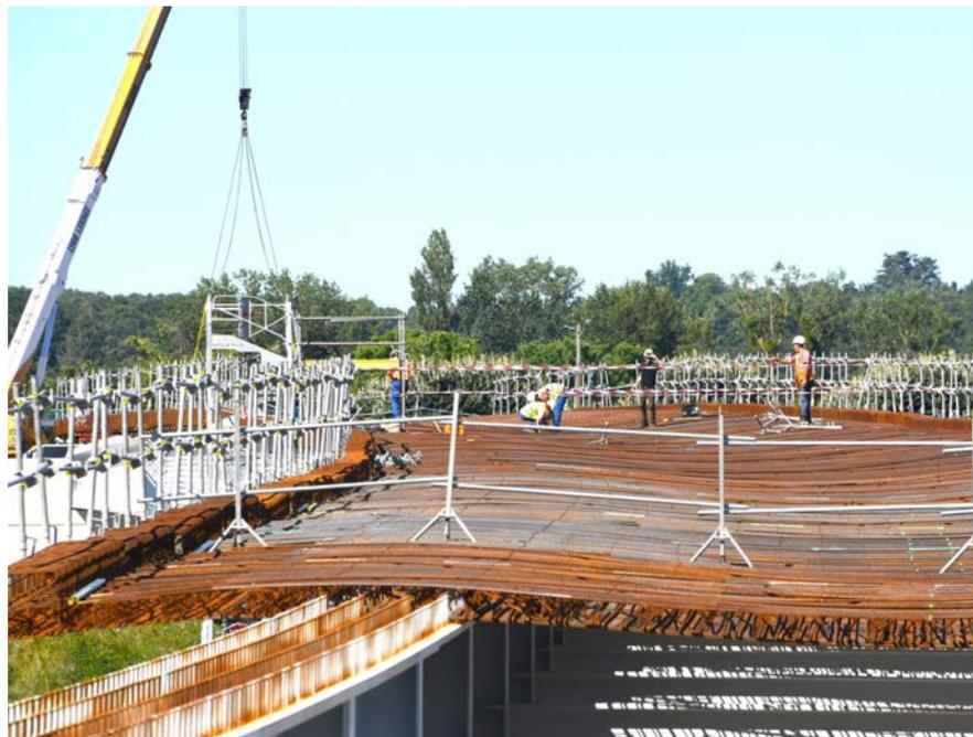
Ferrailage de l'ouvrage principal avant la mise en place des équipages mobiles
