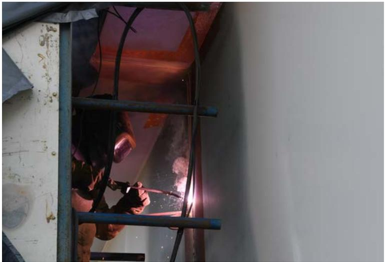
L'assemblage des poutres se poursuit avant le troisième et dernier lancement de la charpente, fin avril.
