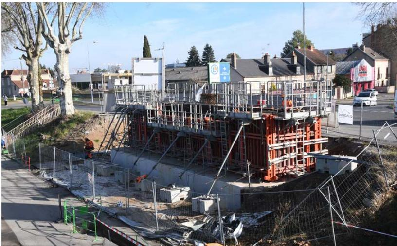
Coffrage et bétonnage de la culée qui fait la jonction avec le Cours de Bercy.
