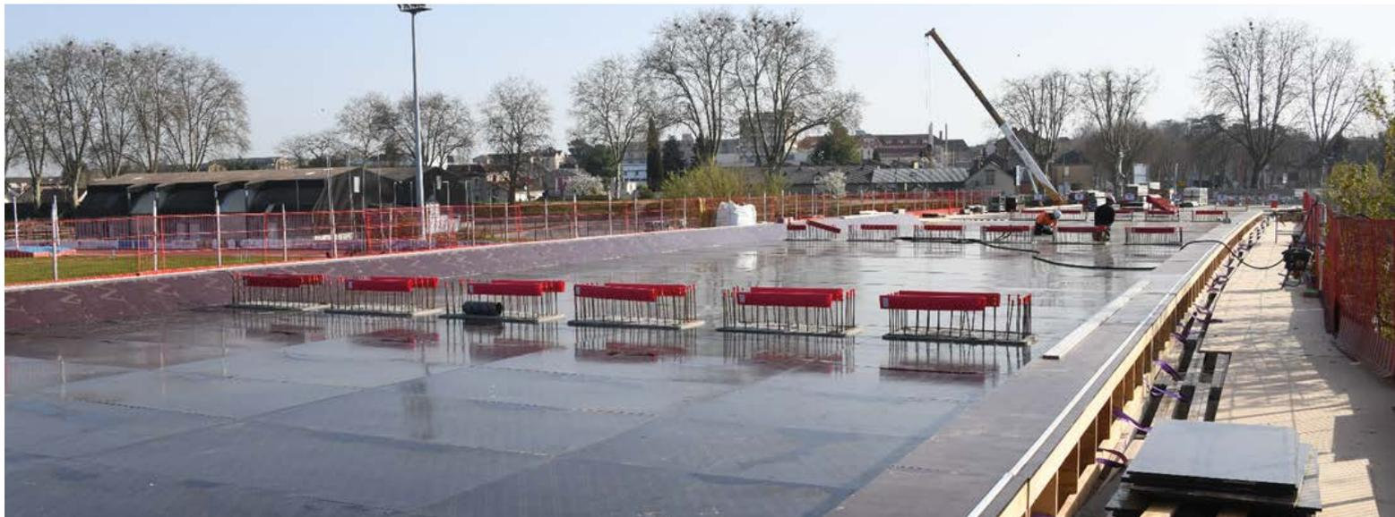
Plusieurs étapes sont nécessaires à la réalisation du tablier. Mise en œuvre de l'étaieiment du tablier, coffrage et ferraillage.
