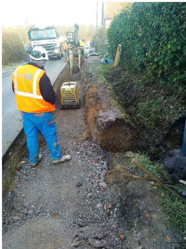
Travaux de construction du réseau EU à GOUISE
