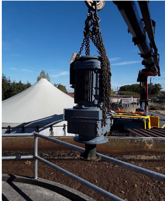
Remplacement du motoréducteur de la turbine 1 à la STEP de BESSAY-SUR-ALLIER
