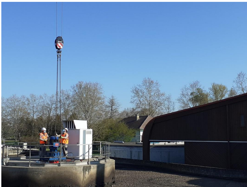
Renouvellement de l'ensemble moteur et réducteur de la turbine 6 à la STEP des Isles
