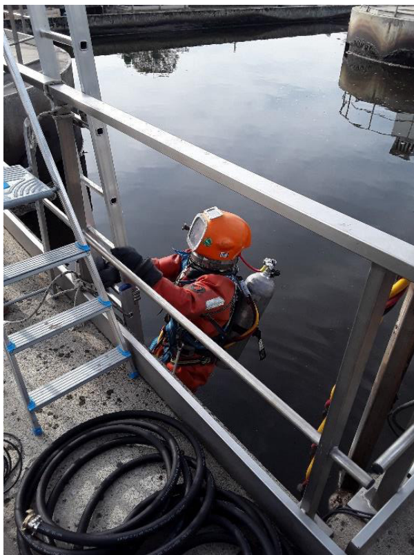
Remplacement des pieds de guidage des agitateurs du bassin d'aération de la STEP des Isles
