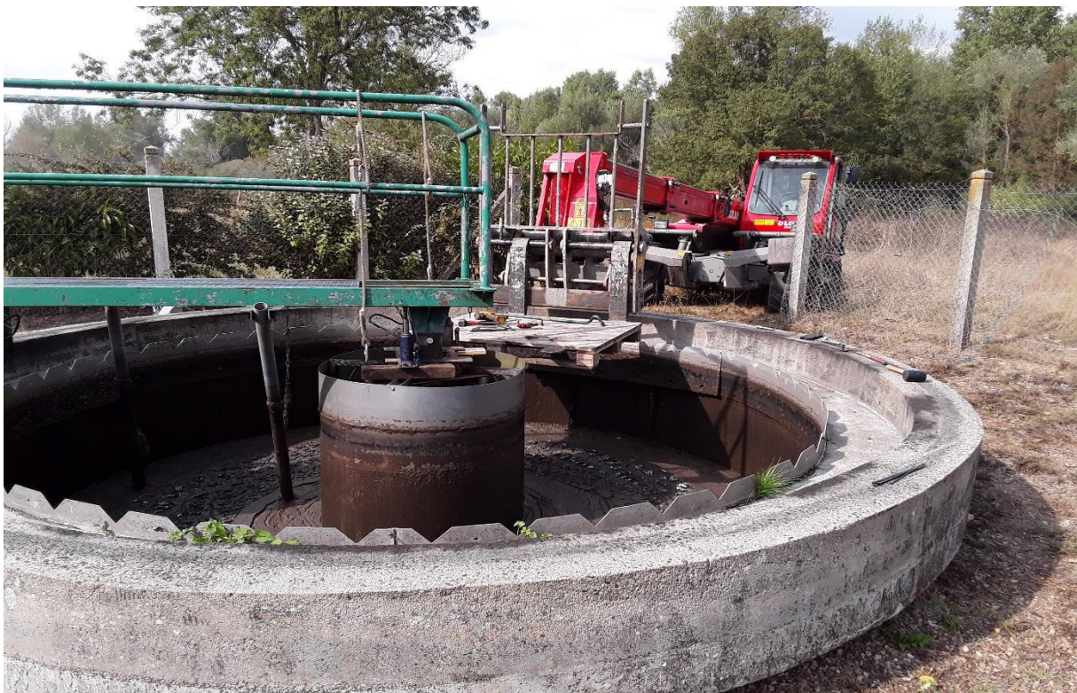
Remplacement de la couronne du clarificateur de la STEP du Veurdre
