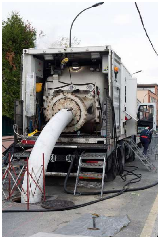
Travaux de chemisage
