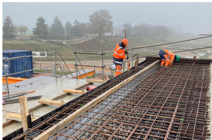
Ferrailage de l'about du hourdis, du côté de La Madeleine
