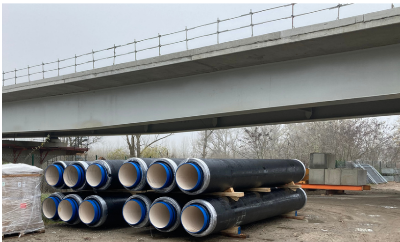
En janvier, les canalisations d'eau potable seront posées : des tuyaux en fonte de 500 mm de diamètre.
