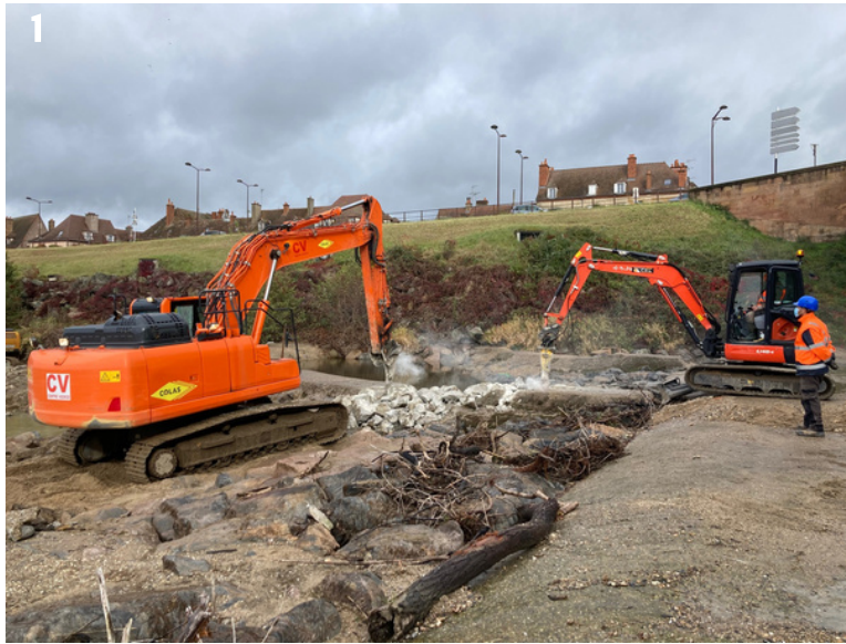
Photo 1 : Démolition de l'ancienne passe à poissons. Photo 2 : Un diagnostic archéologique est en cours sur ce chantier. Photos 3 : La culée rive gauche est terminée.
