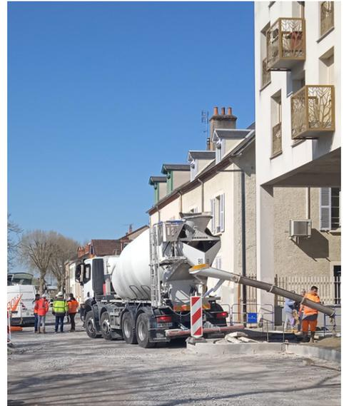
Les travaux se poursuivent Cours de Bercy (ci-dessus). Côté nord, les bordures et trottoirs sont en cours de bétonnage. Le chantier se poursuit de l'autre côté de la chaussée, au sud. L'éclairage public a été remplacé. Sur l'ouvrage principal (ci-dessous), la couche définitive de l'enrobé a été appliquée et les véhicules de chantier peuvent désormais circuler sur le deuxième pont.
