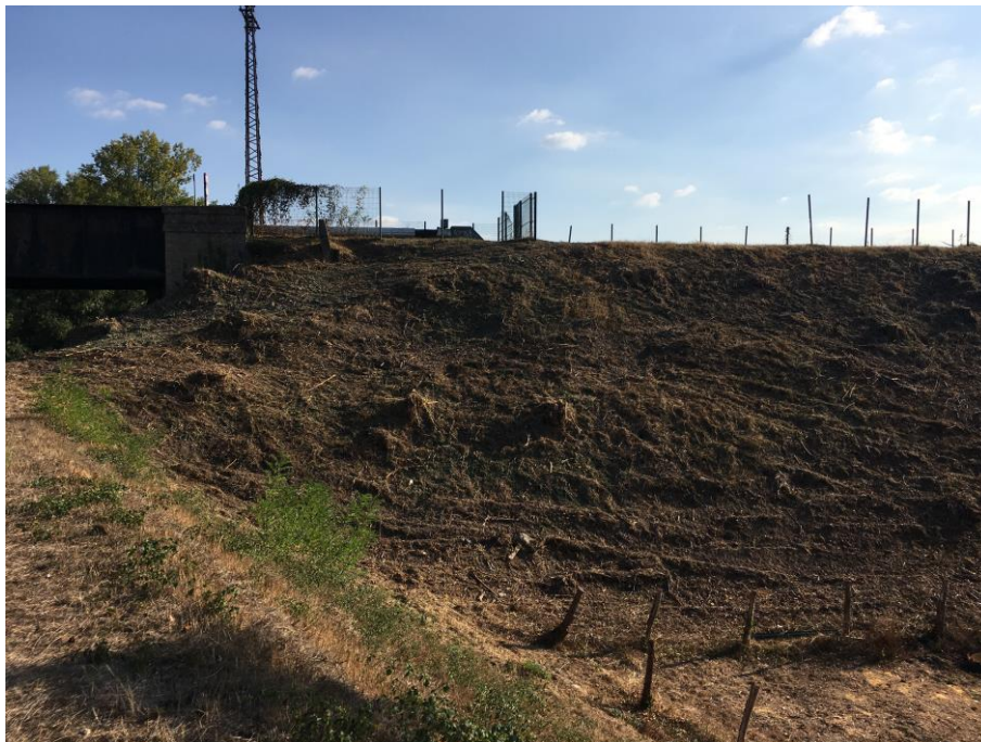
Fig. 2. Vue vers l'emplacement de la future rampe d'accès
